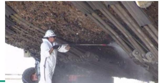
**Korrosion** unter Foulingschichten und bioinduzierte Korrosion durch Mikroorganismen führen in verschiedenen Bereichen zu Schäden und hohen Betriebskosten
